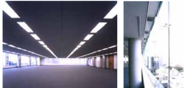
写真 1 無耐火被覆工法の建物例
